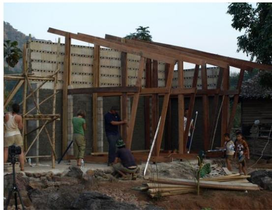
FIG 24. LEVANTAMIENTO DE LA ESTRUCTURA DE MADERA
