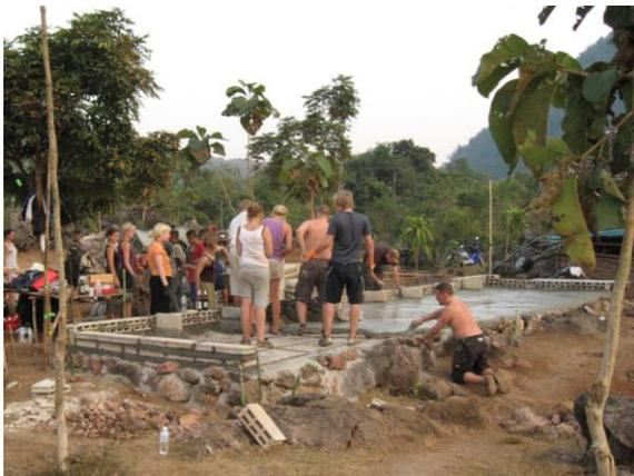
FIG 23. CONSTRUCCIÓN DE LA PLATAFORMA DE ROCAS
