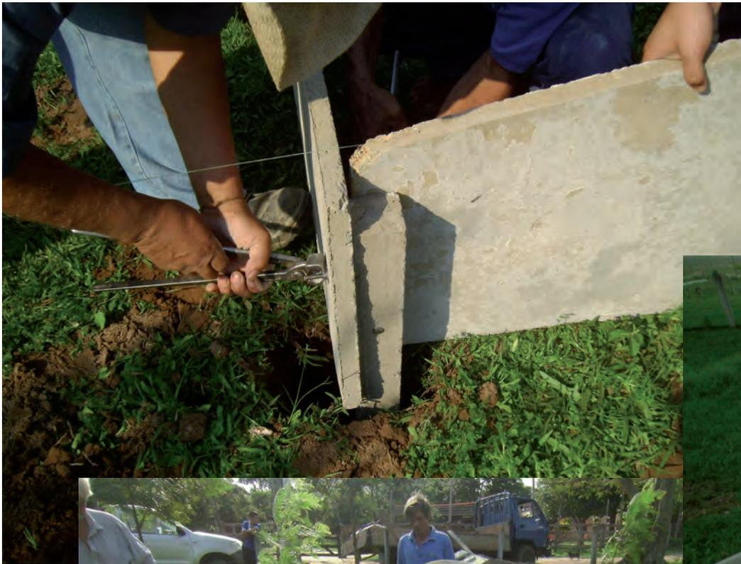
Ajuste de partes de ferrocemento y hormigón armado por medio de elementos de sistema seco, en este caso bulones.
