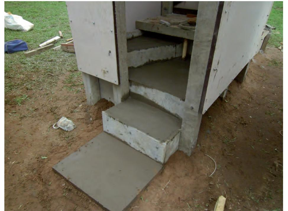
Detalles constructivos de fijación de columnas, de fijación de placas cementicias, detalles de tapas y terminación piso
