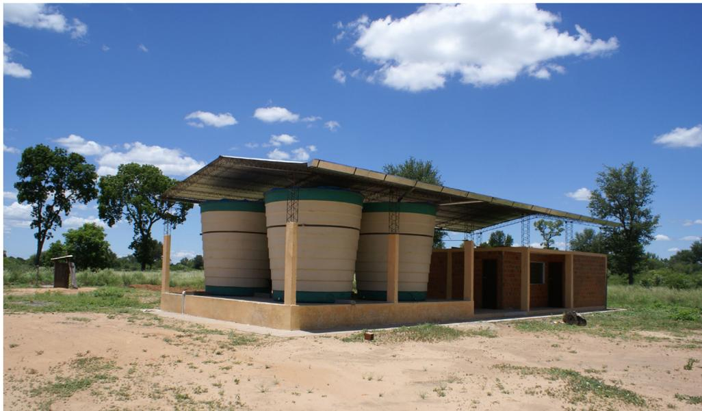
Uno de los sistemas montados en la localidad de Casuarina es un tajamar recubierto con membrana de polivinilo. Un sistema de elevación en base a un molino de viento y cuatro tanques de fibra de vidrio con un techo de protección, completan el sistema.
