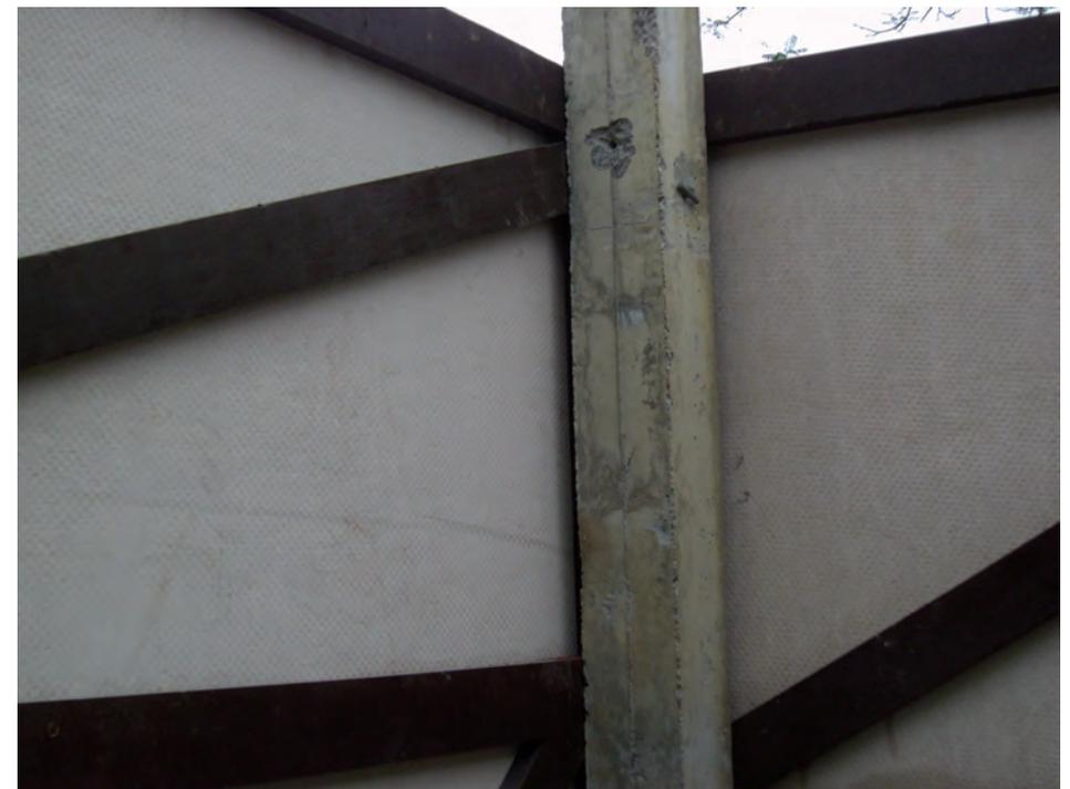
Montaje de la cabina y detalles constructivos de los lados de la misma en relación a las columnas de soporte y al bastidor de madera pintada.
