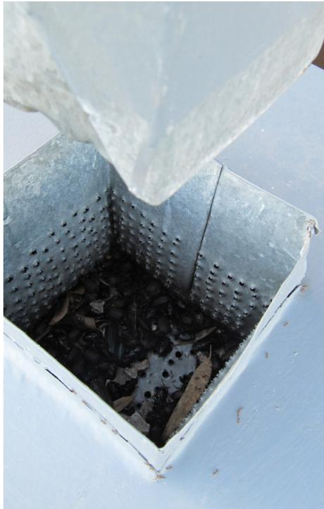
*Detalles constructivos de filtros contra la entrada de hojas o similares, "cuchara" para limpieza de primeras aguas y elemento móvil que se acciona para poner o sacar la "cuchara".*
