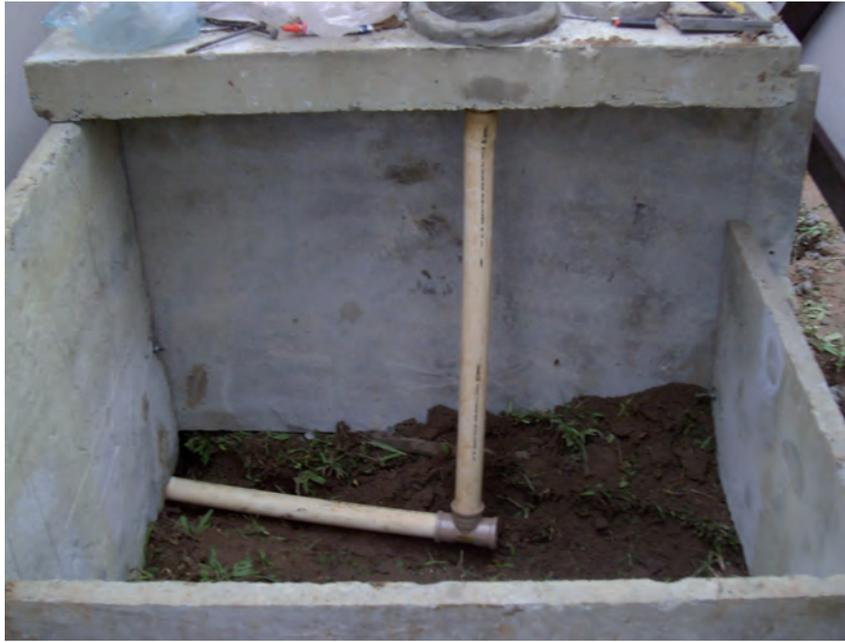
Detalle de la cañería de separación de orina y el área de absorción de la misma al lado de la cabina. La foto siguiente muestra los escalones con el hormigón recién cargado, previo al uso de la cabina.
