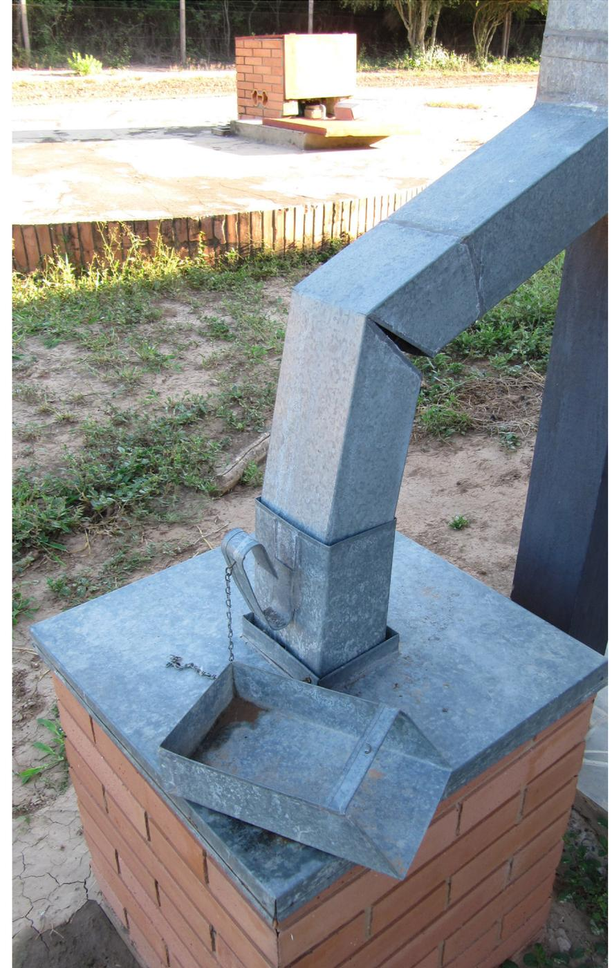
Las canaletas que se observan disponen de una sección de 33 cm de desarrollo con bordes rigidizadores y con cintas de chapa para mantener la sección uniforme cada metro. Los soportes para canaletas se disponen a distancia de 80 cm uno de otro.
